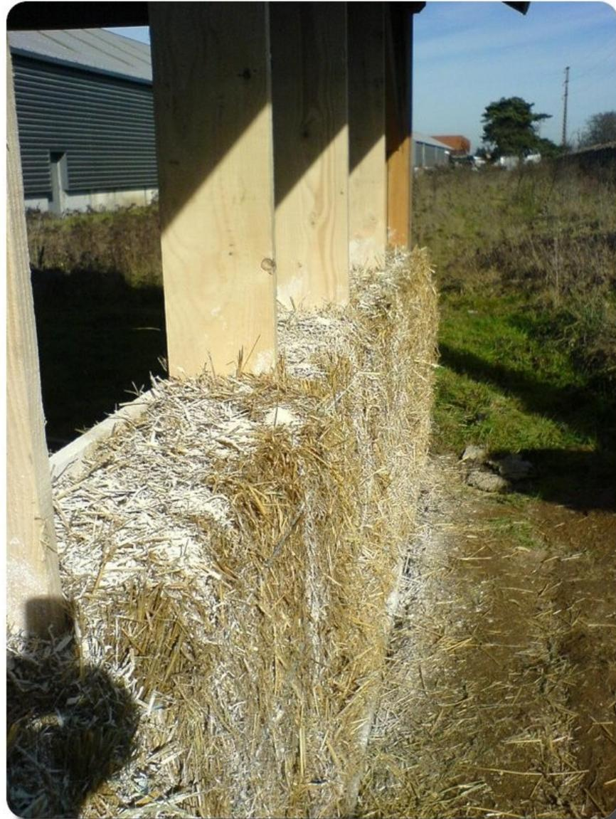
Pour l'exemple, pose de planche pour pouvoir fixer un bardage intérieur.
