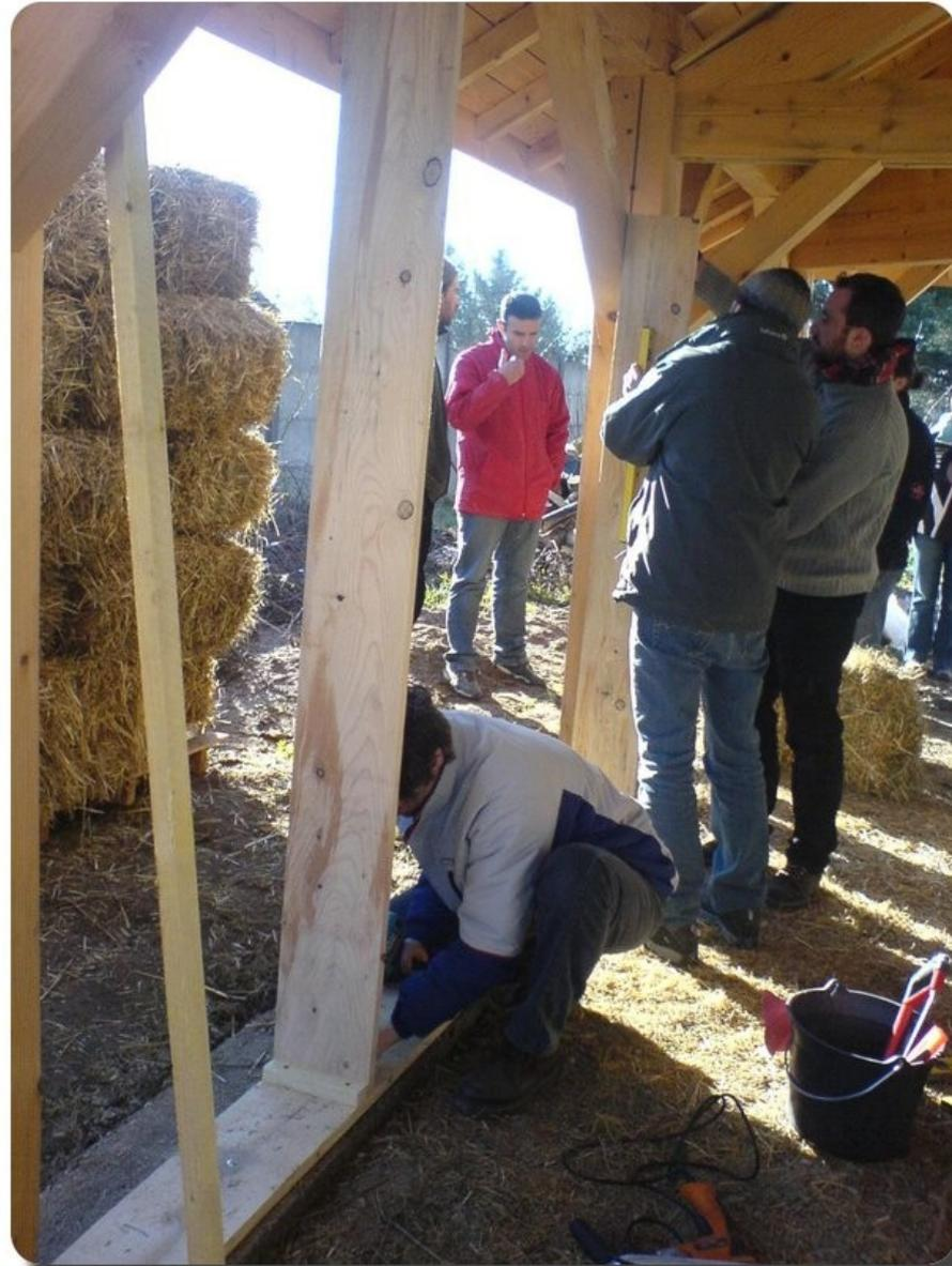
Théoriquement, c'est la lisse haute qui vient fermer le « caisson ». La, pour l'exemple, on a utilisé une charpente traditionnelle qu'utilise les apprentis couvreur du centre pour se faire la main.
