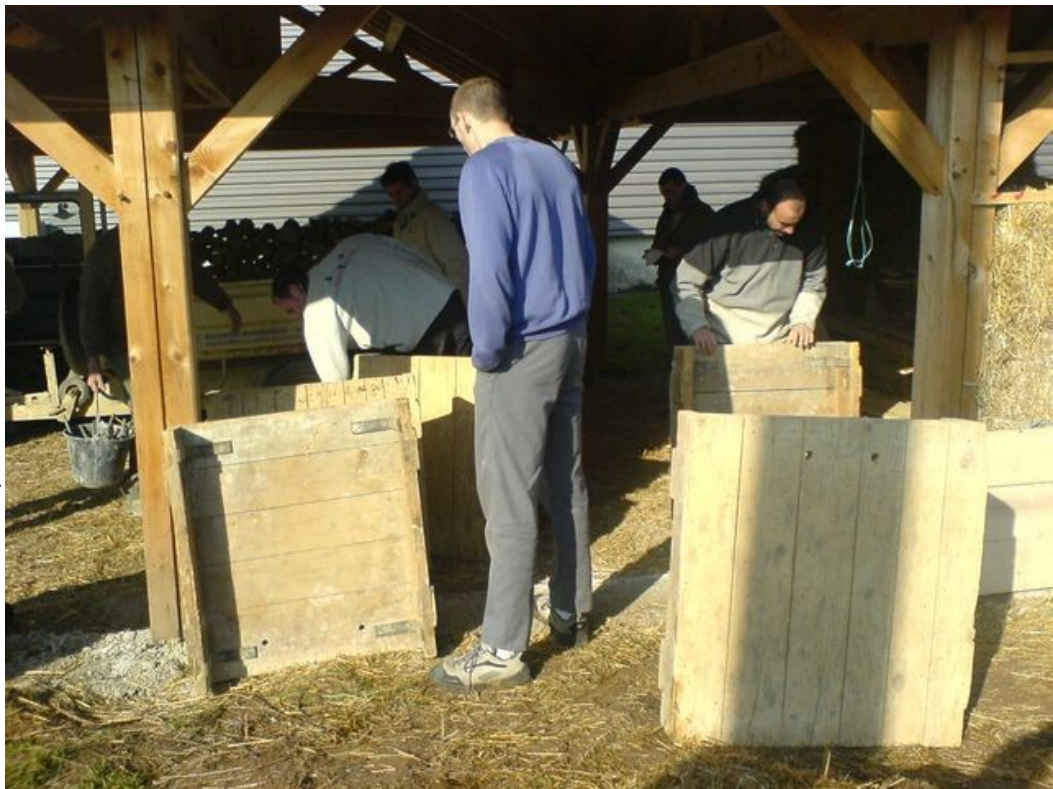
Mise en place des « banches »
