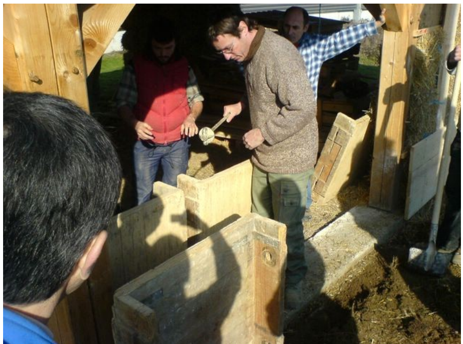
Les banches sont serrées grâce à ces grosse vis, genre ferraille à béton.
